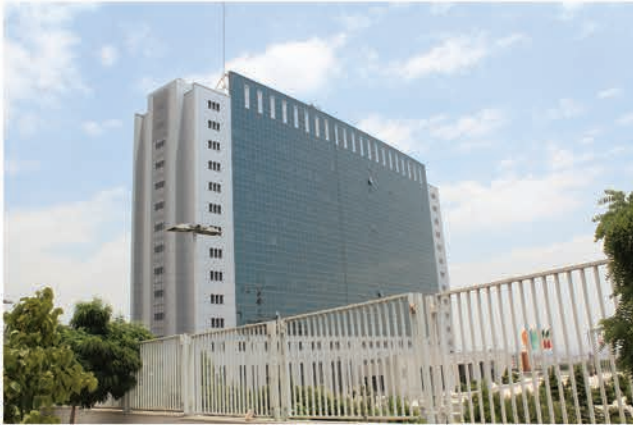
ساختمان وزارت نیرو
